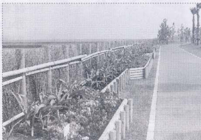
防風目的にマリンポートに設置された竹ソダパネル
