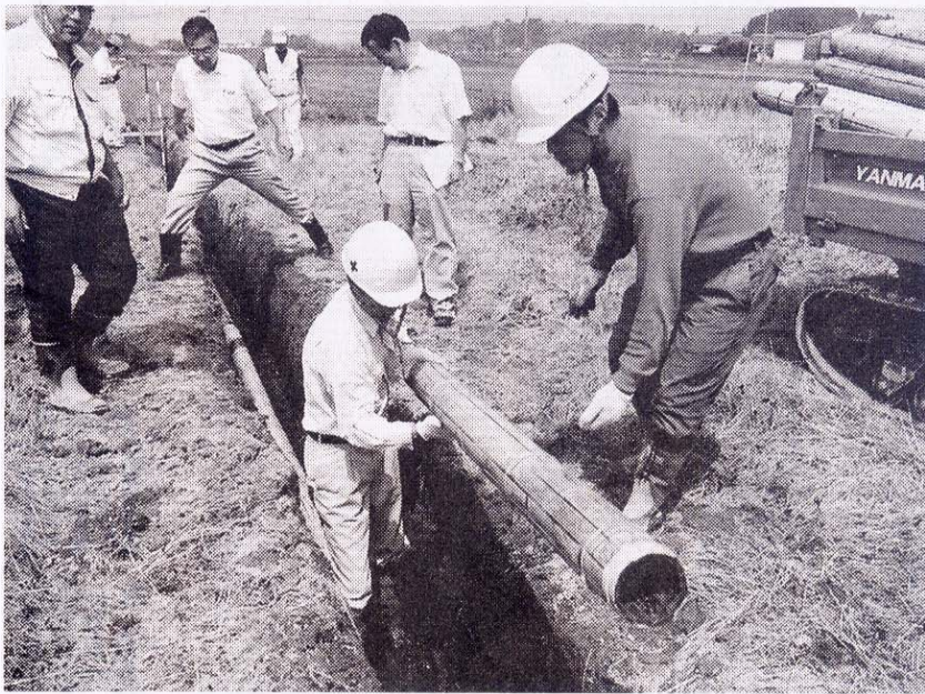
竹管を使った暗きよ排水の試験施工
