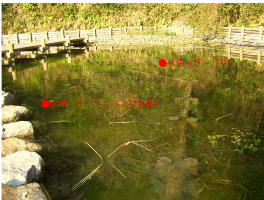
●池底盤段差工
