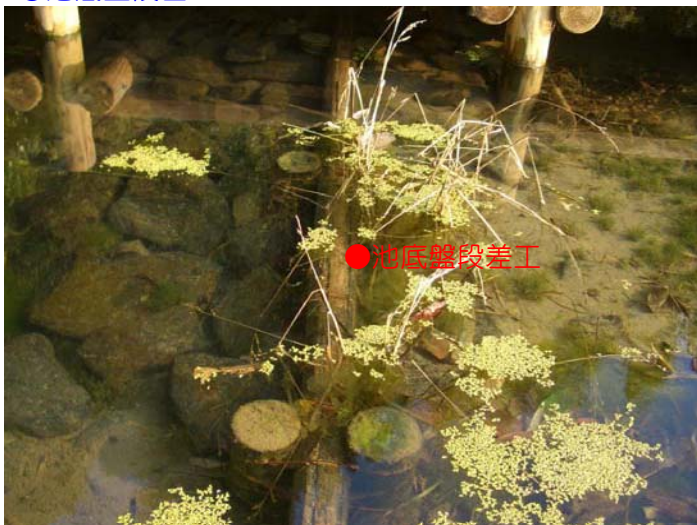
●池底盤段差工
