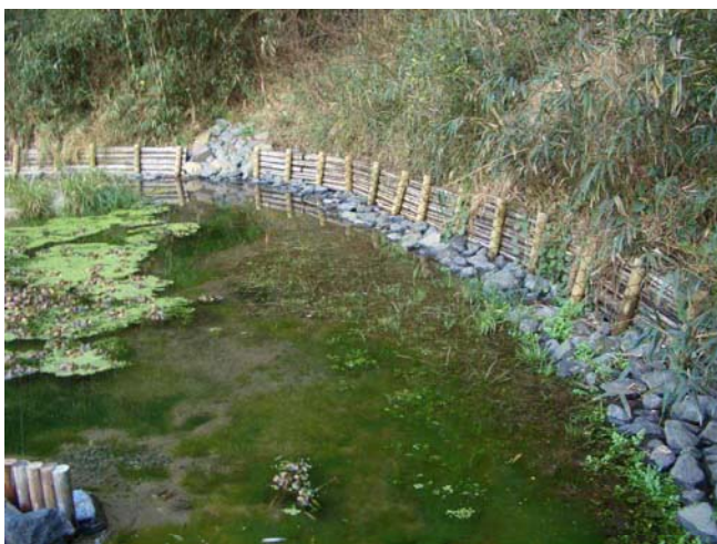
●竹ソダロール護岸工
