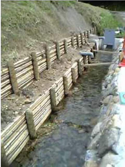
●竹ソダロール護岸工
